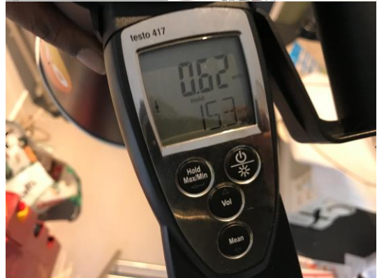
De werkkamer 1 is voorzien van vier stuks luchttoevoerventielen
